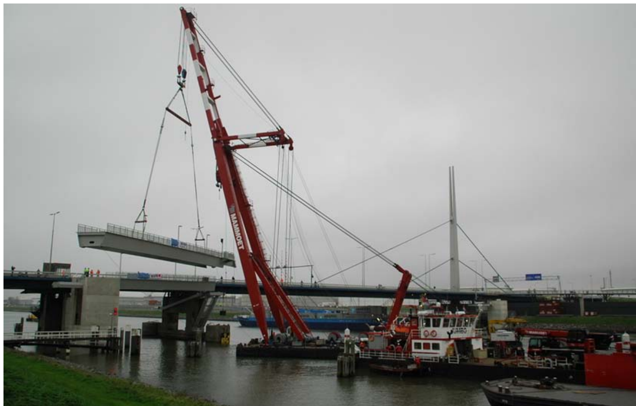
Boven afgebeeld een actie van Mammoet, Schiedam het betreft hier het inhangen van een fietsbrug aan de Harmsenbrug die over het Hartelkanaal in de N57 ligt
