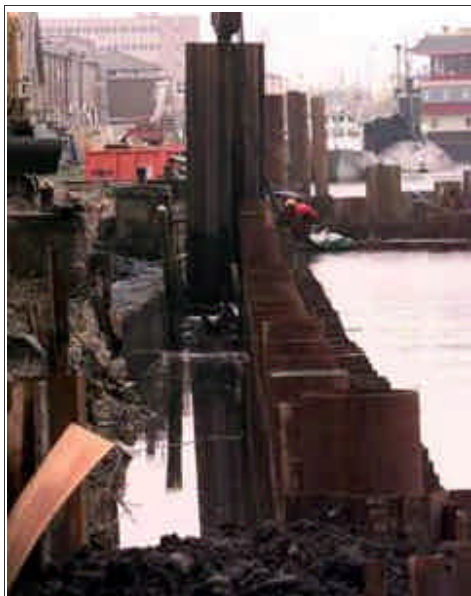
Om aan de kade te kunnen werken is een voorzetwand geplaatst. Foto Michel van Zwieten
